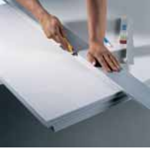
Knauf Vidipan maket bıçağı ile kesilir
