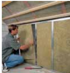
Çatı altı duvarına yalıtım malzemesi döşenmesi
