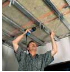
TC profillerin tavana agraf ile tespit edilmesi
