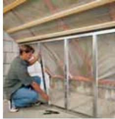
Çatı altı duvarında profillerin ayarlanması
