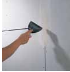
Derz Fugagips veya Uniflott ile doldurulur...
