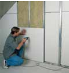
Dikeylerde 250 mm mesafe ile vidalama yapılır
