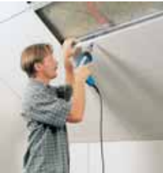
Fire olmaması için bir taraftan vidalamaya başlanır
