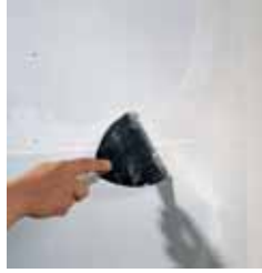
...sertleştikten sonra ince bir tabaka daha Fugagips veya Uniflott çekilir
