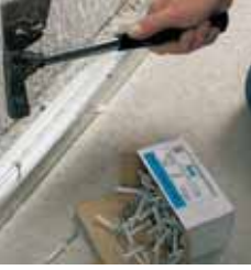
DU Profili plastik dübel ve vida kullanılarak zemine tespit edilir
