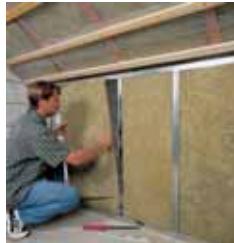
Çatı altı duvarına yalıtım malzemesi döşenmesi
