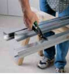
DC Profillerinin boyu sac makası kullanılarak ayarlanır...
