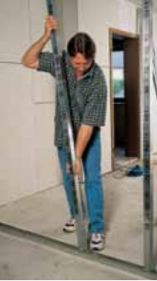
.. ve uygun aks aralığı ile DU Profili çerçevesine yerleştirilir
