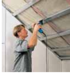
TC profillerinin çatı mertebğine agraf ile tespit edilmesi
