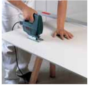
Knauf Vidipan dekupaj testere kullanılarak da kesilebilir
