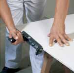
Kırılan kenar rendelenerek düzeltilir
