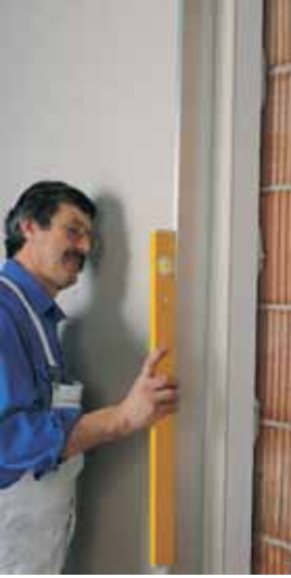
Vidipan yapıştırma uygulamasından sonra yüzeyin terazide olduğu kontrol edilmelidir
