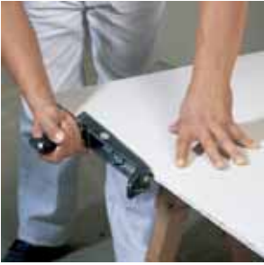
Kırılan kenar rendelenerek düzeltilir
