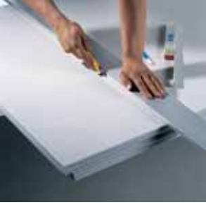
Knauf Vidipan maket bıçağı ile kesilir
