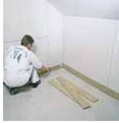
Kenar yalıtım şeridinin döşenmesi
