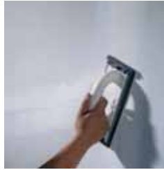
Macun katılaştıktan sonra zımparalanarak düzeltilir..
